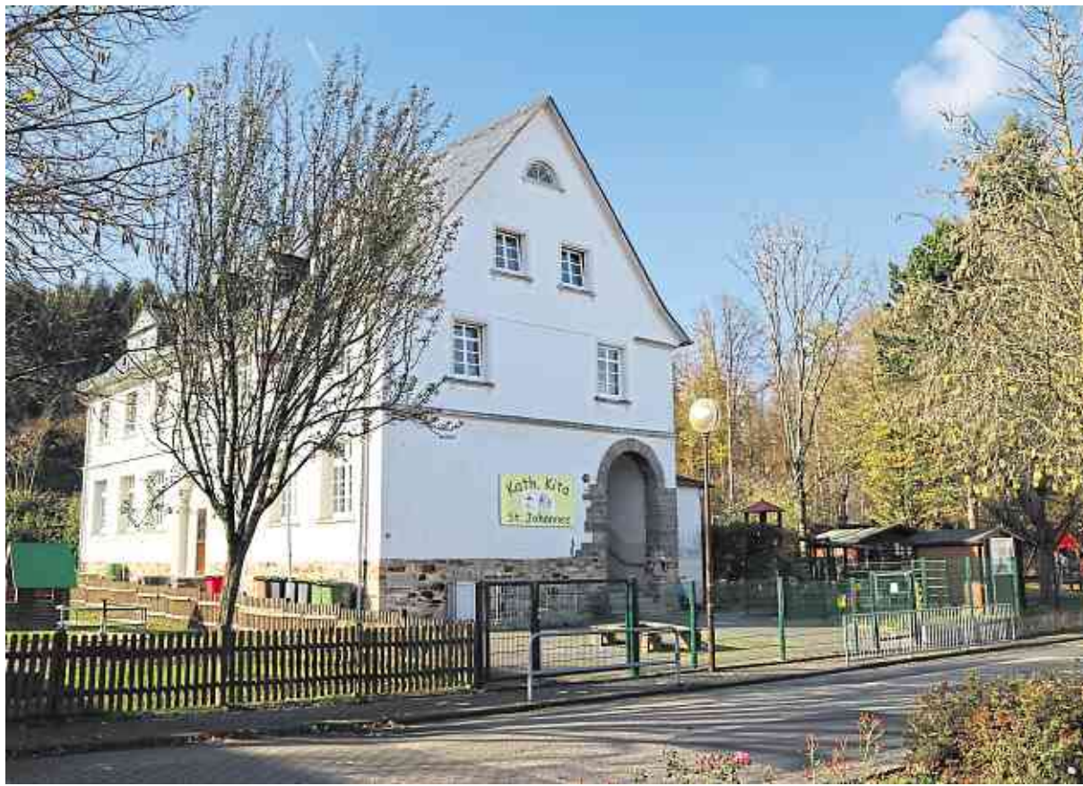
In der Kindertagesstätte in Horressen wurden bei einer baubiologischen Untersuchung weitere Mängel festgestellt, darunter Schimmelpilzbefall im Keller, in der Küche und einem Bad.
